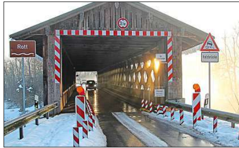
Der Ersatzneubau für die Rottbrücke bei Neuhaus am Inn ist ein umstrittener Posten im Haushaltsentwurf. – Foto: Archiv Brunner
